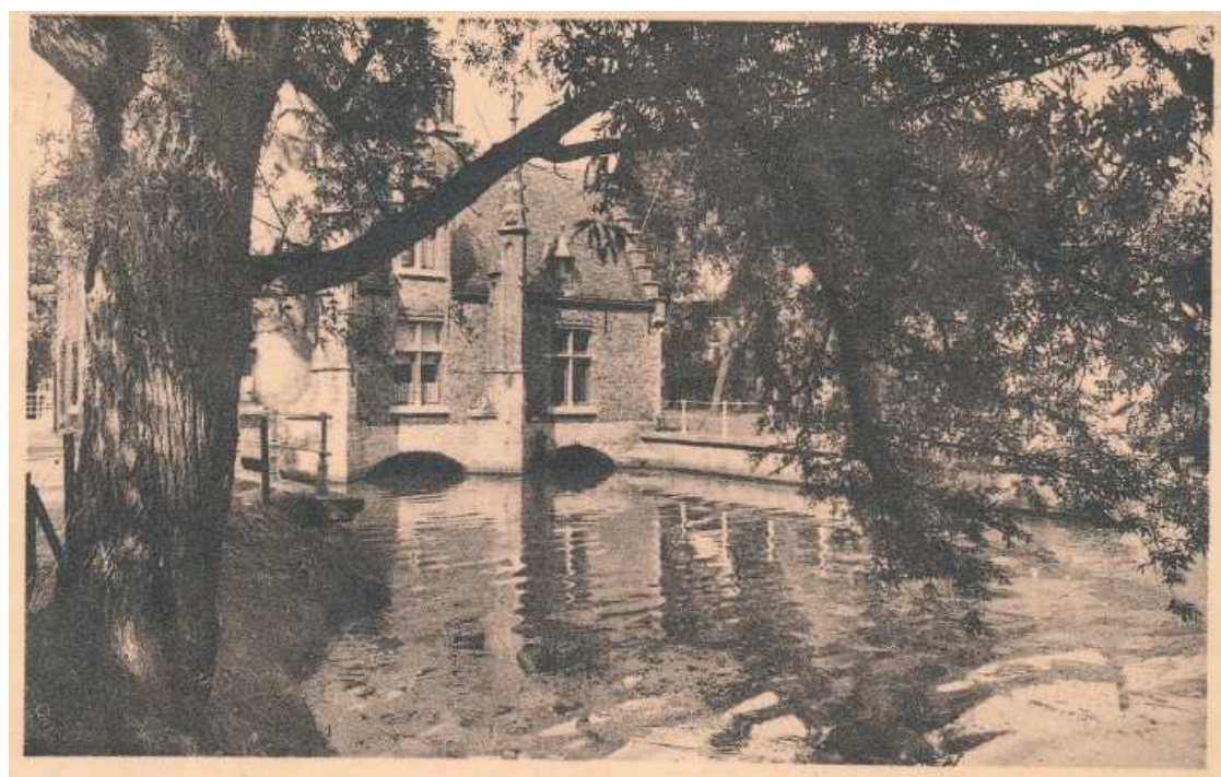
Punt 15 : Sashuis aan het Minnewater Point 15 : Ecluse au Lac d'Amour
